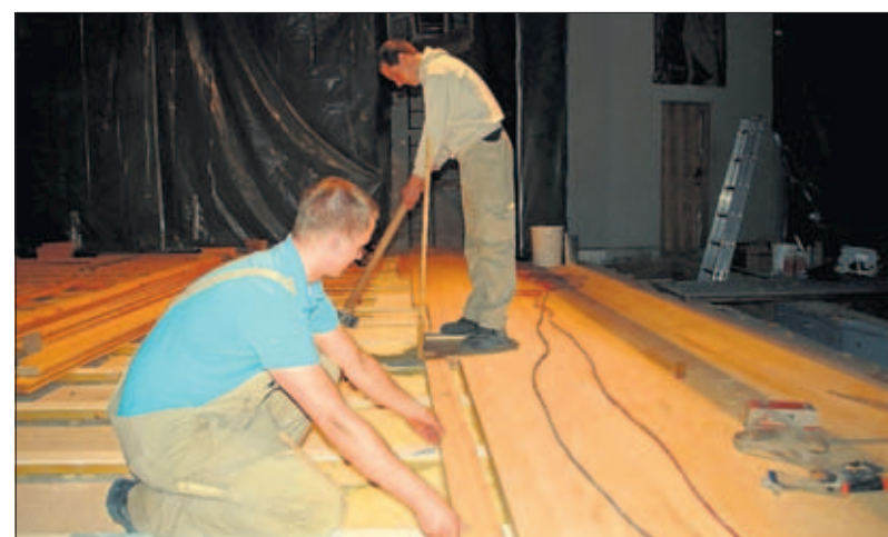
Haben über den Sommer einen neuen Bühnenboden im Barlach-Theater verlegt: André Hammel (vorn) und Manuel Neumann. Foto: Christian Menzel
